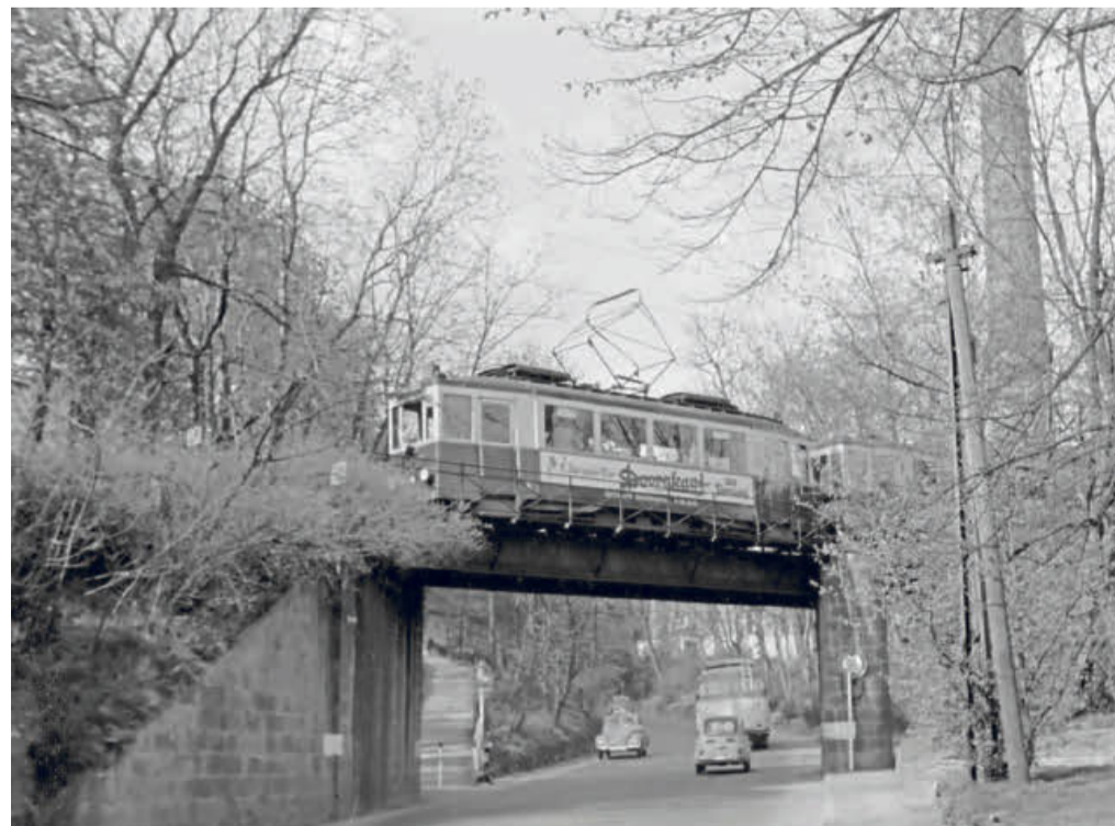
Die Brücke der Kleinbahn über die Extersche Straße (heute Bismarckstraße) in Bad Salzuffen musste erneuert und dabei etwas verschränkt werden. Foto: Frenz
